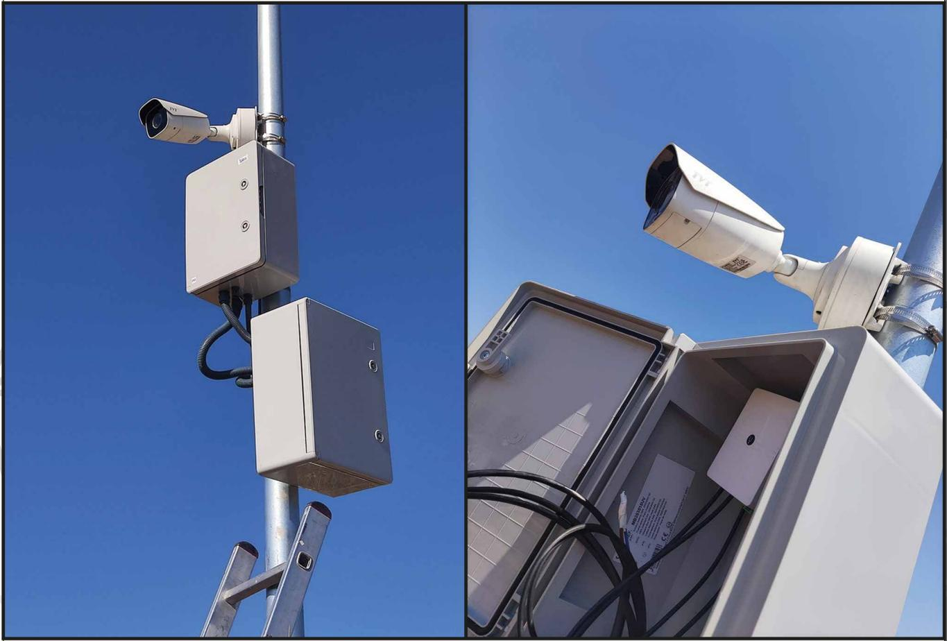
El módulo ZX22 dispone de un doble terminal de alarma para comunicar al panel central no sólo las posibles manipulaciones o problemas en la cámara sino posibles sabotajes en la caja o los módulos incluidos.
