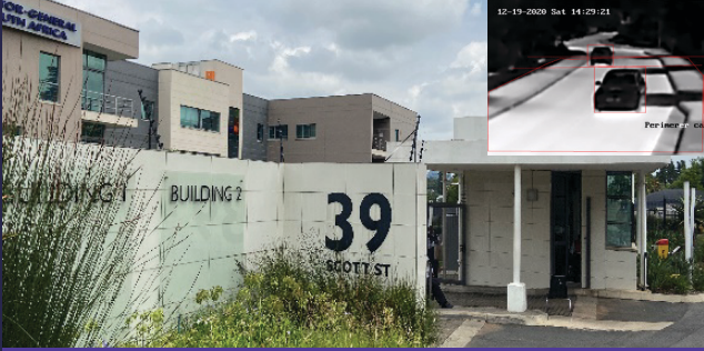
Entrada del edificio de oficinas
