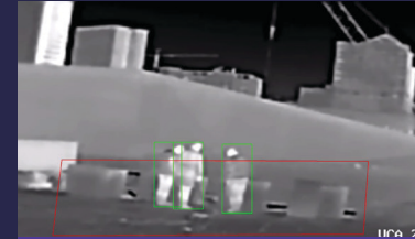
Áreas de construcción
